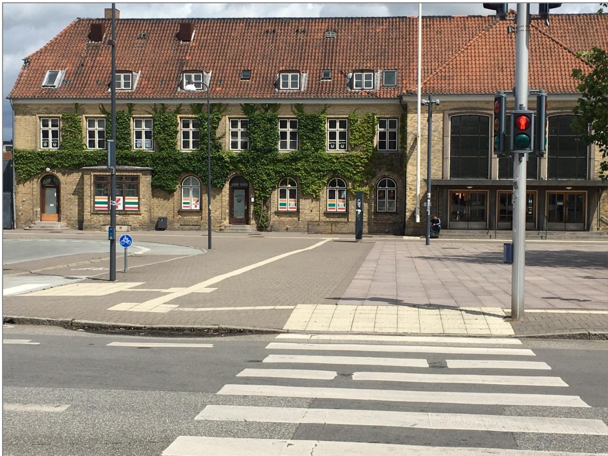
Figur 1: Signalkryds for enden af Jernbanegade ved Næstved Station
